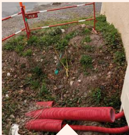
Enfouissement réseaux électriques avenue Jean Faure 255 185 €
