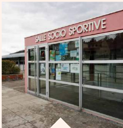
Rénovation thermique centre Socio Sportif 200 000 €
