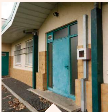
Construction vestiaire Foot 400 000 €
